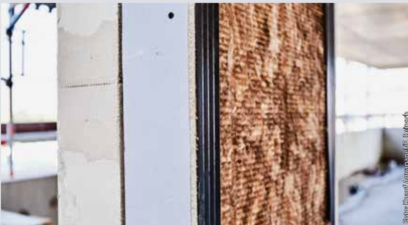
Außen Zement, innen Gips. Mit einer solchen Hybridkonstruktion kann der Planer flexibel auf Anforderungen reagieren. Jedes Plattenmaterial wird dort eingesetzt, wo es wirtschaftliche oder Technische Vorteile bietet.
