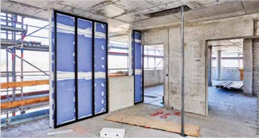
Das Ständerwerk der hinteren Schale. Die blaue Diamant-Platte ist die innenseitige Beplankung der vorderen Schale. Die realisierten Wandstärken betragen 327,5 mm plus VHF bei einer Wandhöhe der eingestellten Konstruktion von jeweils etwa 3.000 mm.
