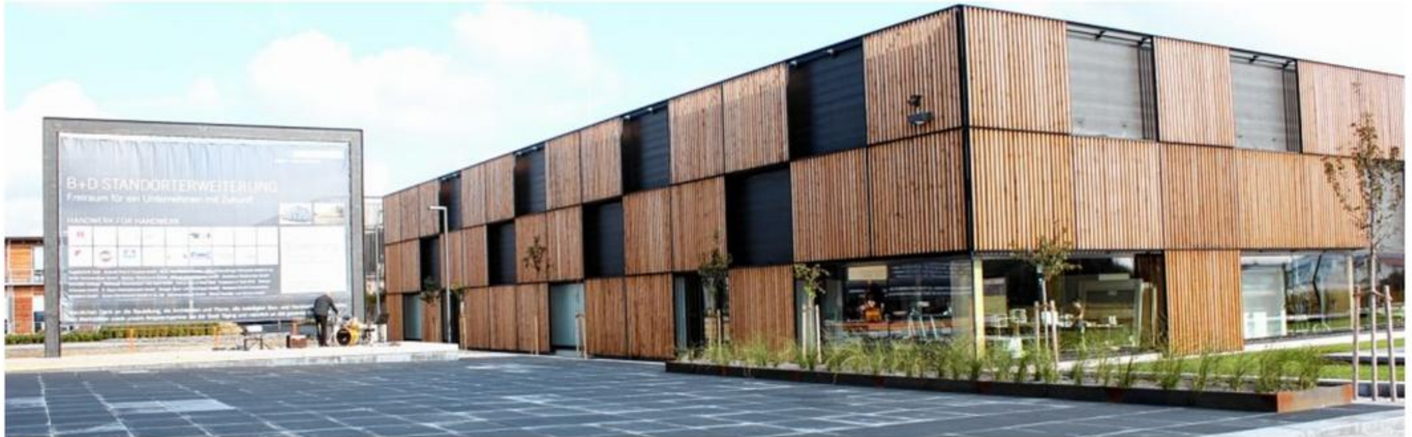
Sowohl die neue Holzmanufaktur als auch der Büro-Campus der Firma Baiertl und Demmelhuber sind offiziell eingeweiht.
