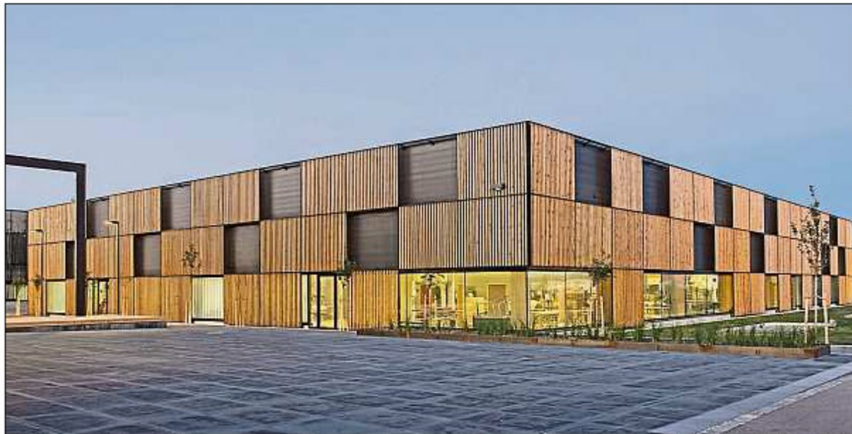
Das neue Werkstätten- und Fertigungszentrum von baiern + demmelhuber mit Kielsteg-Dach.
